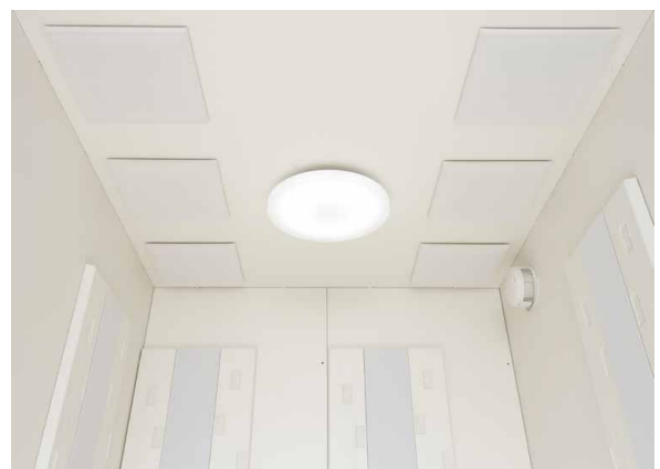
■音場天井パネル/照明器具
